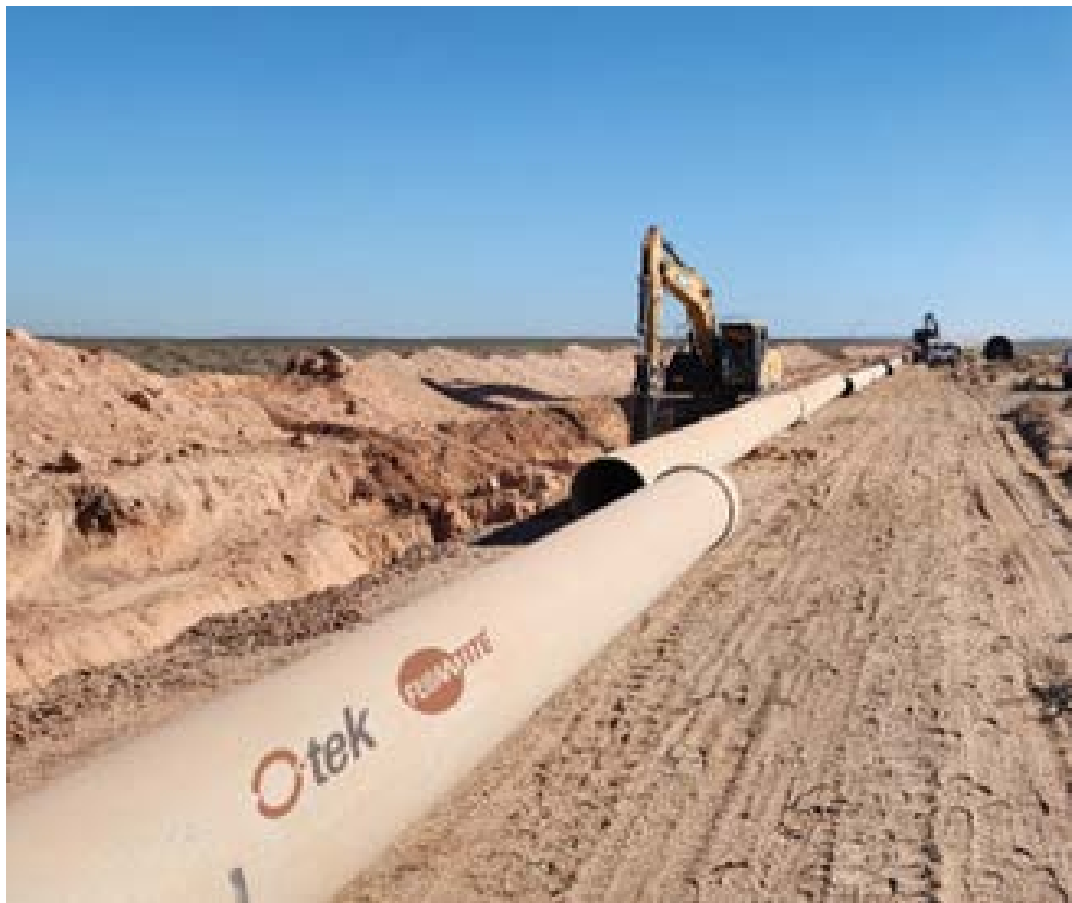
Proyecto para conducción de agua en la región de Vaca Muerta Argentina. Tubería GRP/PRFV suministrada por O-tek.a
